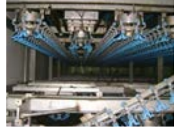
Hava Soğutma Hattı
